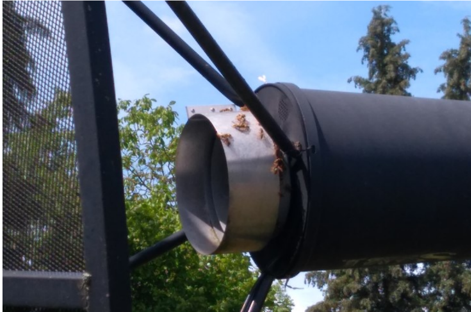
Abb. 2: Kein guter Zeitpunkt für eine Demontage
